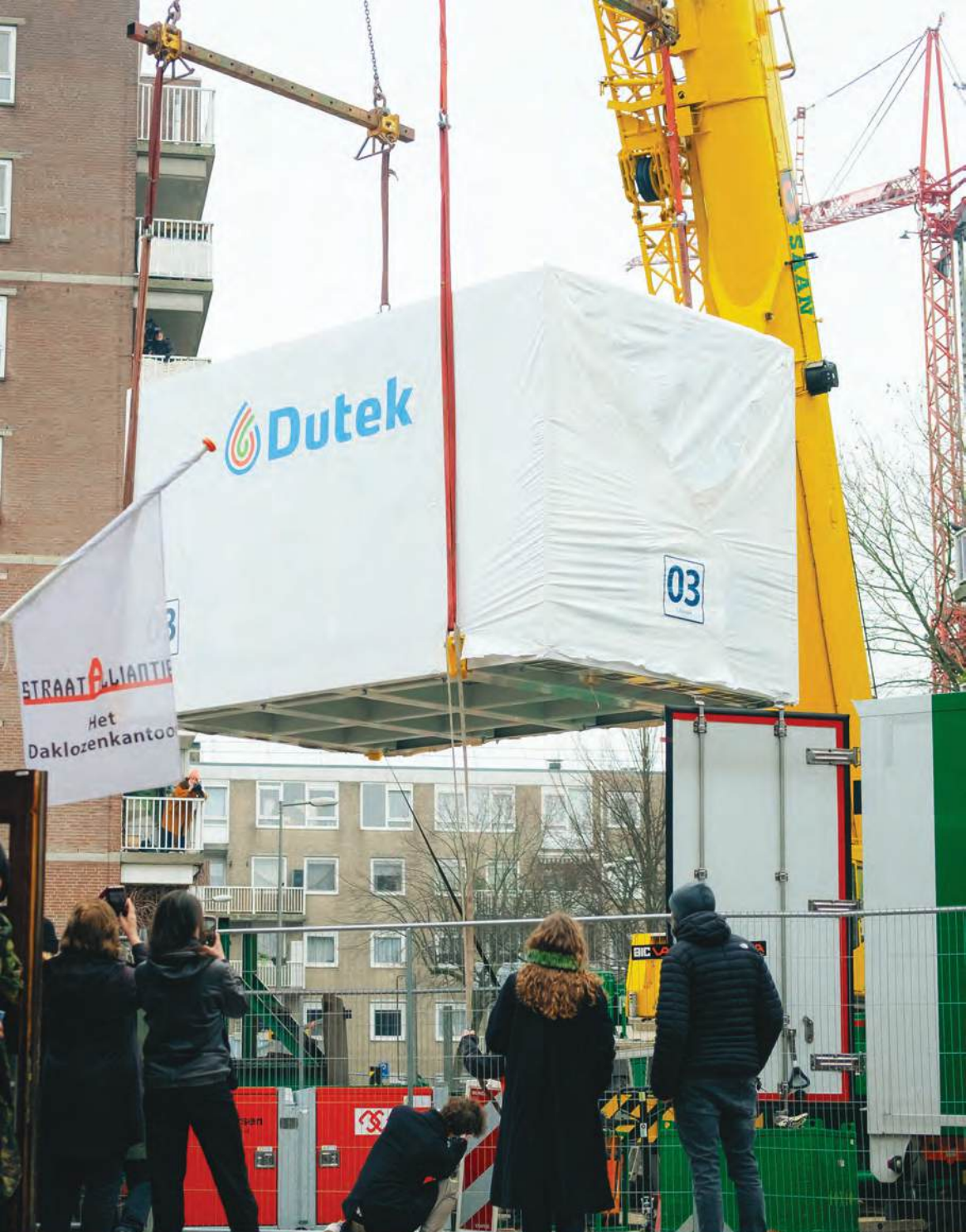
feb '26 - het inhijzen van de eerste warmtepomp (14 ton)
