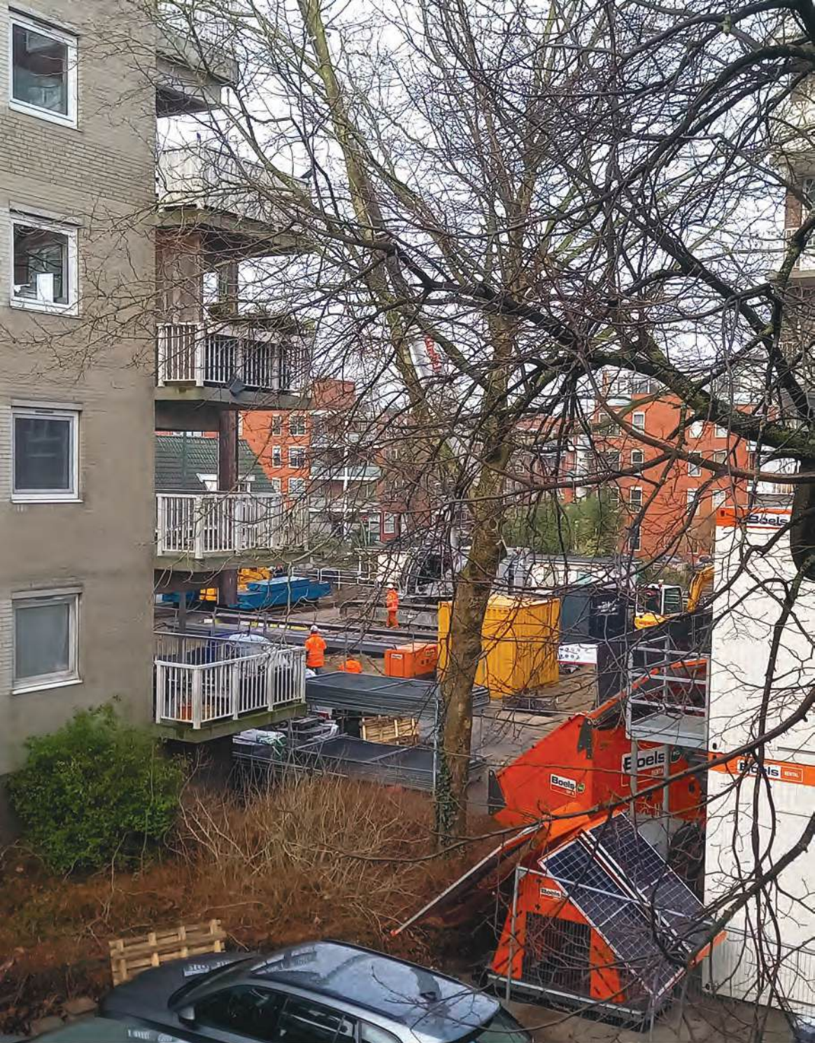
Vorbereitung bouw technische ruimte
